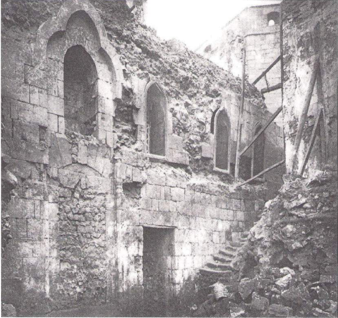
زاوية حسن الرومي (الواجهة الغربية قبل الترميم)
