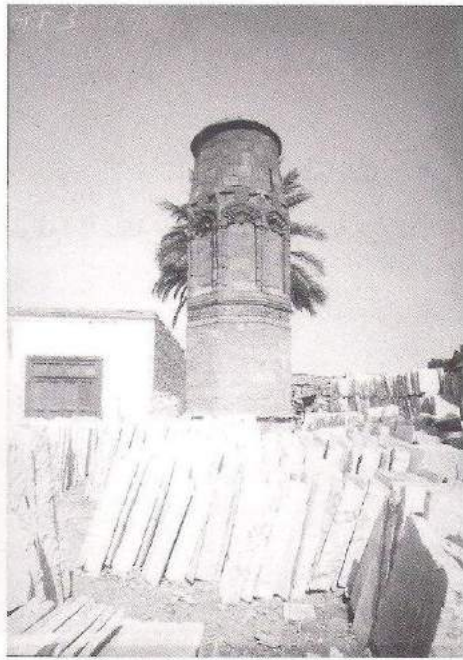
نفس المنارة أثناء إعادة بنائها
