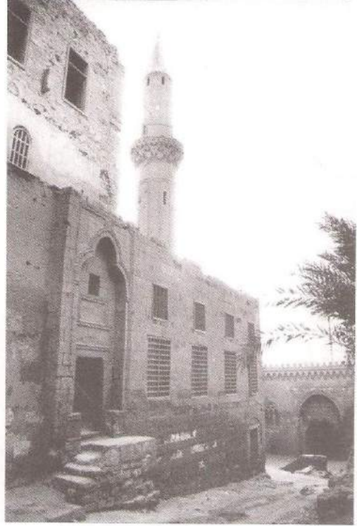
مسجد أحمد كتخدا العزب (الواجهة الشمالية)
